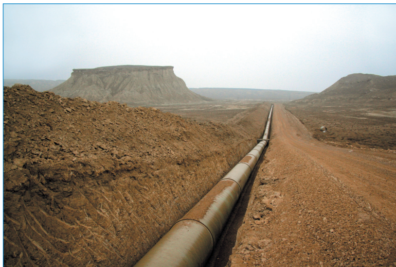
Oğuz-Qəbələ-Bakı su kəmərinin quraşdırılmış hissəsi
